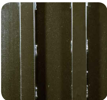
Estructura en acero tubular pintado
